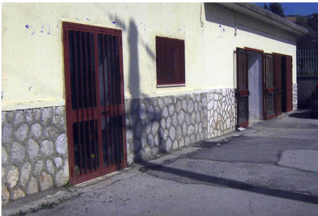
Centrale Sollevamento Caggiano
