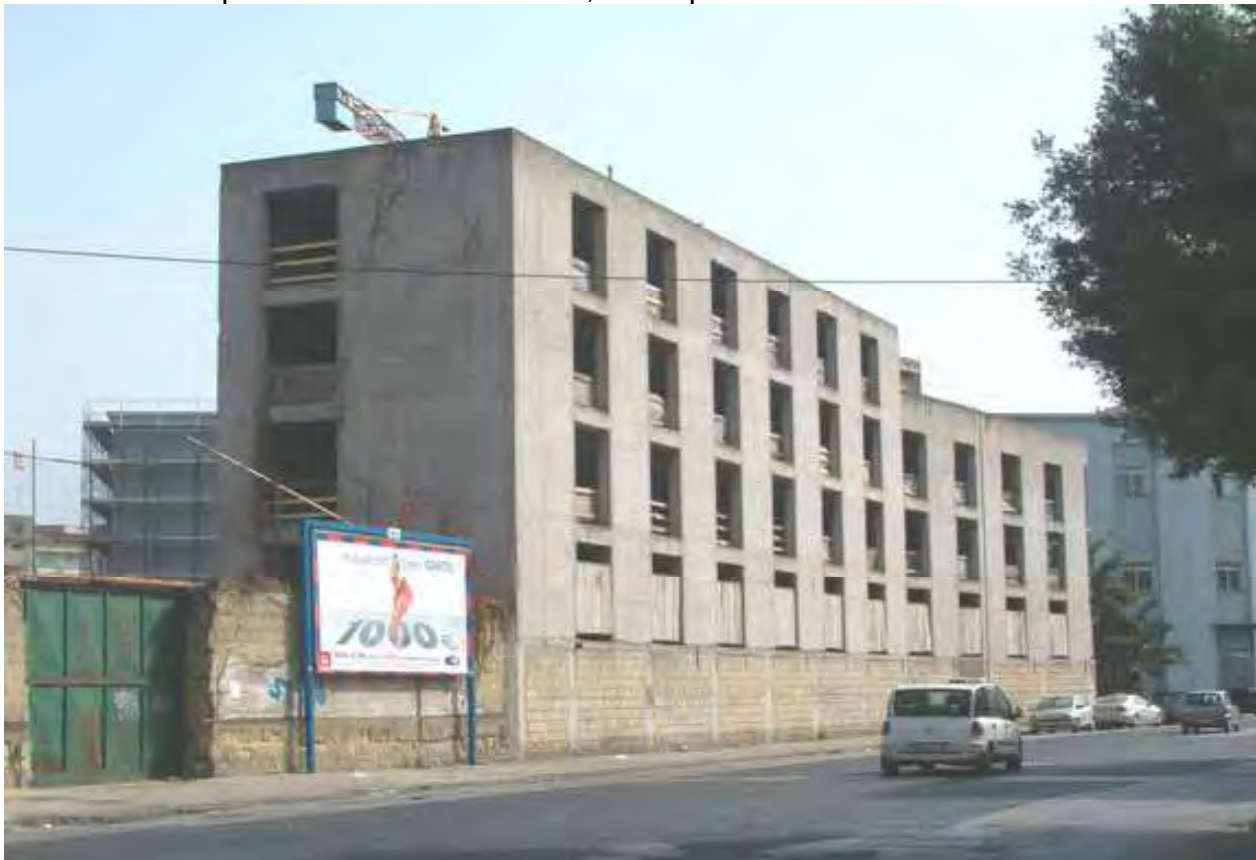
FOTO 1 Primo piano dell'edificio Via Brin, 69 Napoli.
