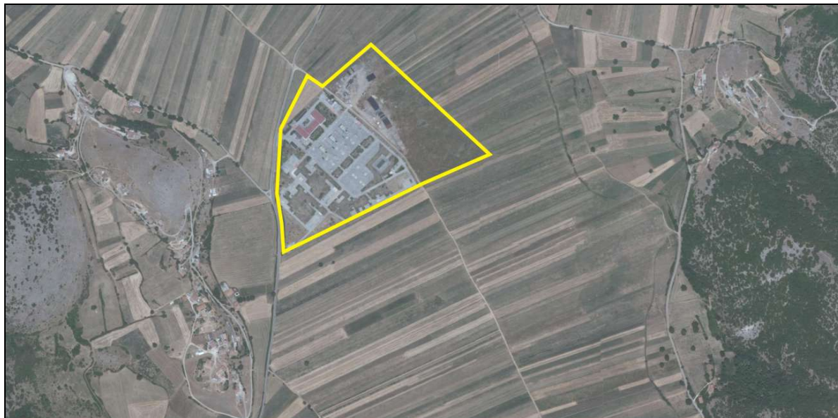
Figura D: Vista dell'area Snam Rete Gas a Montesano sulla Marcellana
