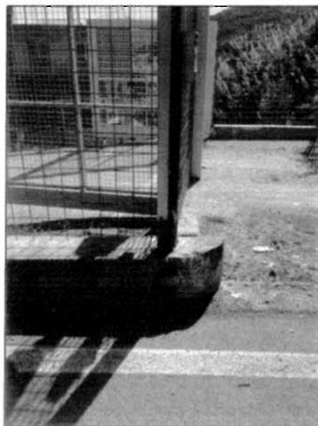
Foto - Vista particolare
