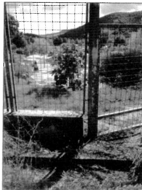
Foto - Vista particolare
