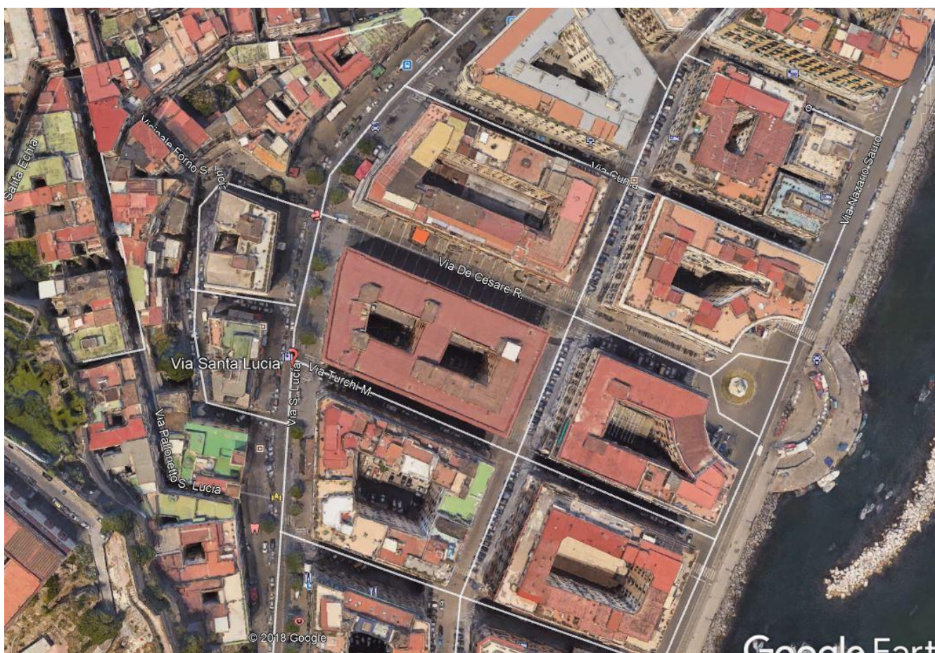
FIG.1 VISTA AEREA AREA OGGETTO INTERVENTO
