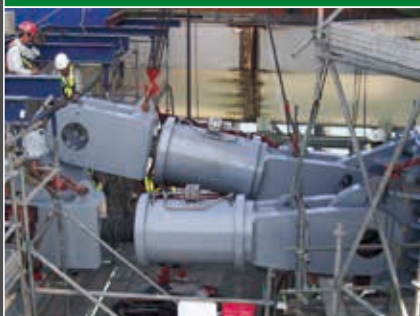
Installazione di dispositivi di vincolo dinamico nello Stonecutters Bridge (Hong Kong, Cina).
