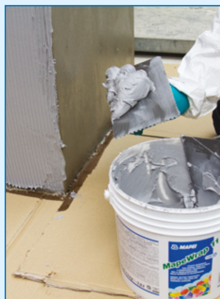
Rasatura con MapeWrap 11 o MapeWrap 12
