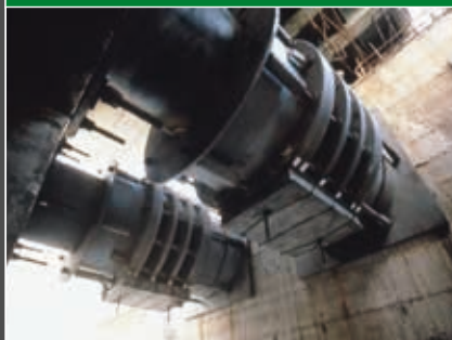
Dispositivi NE installati nel Viadotto Somplago, il primo ponte europeo sismicamente isolato (1974-1976).
