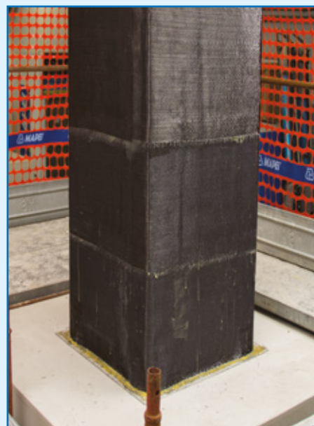
Pilastro confinato con MapeWrap C UNI-AX System
