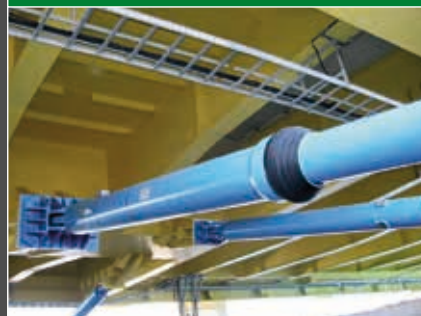
Un dispositivo della serie SR installato assieme a dissipatori viscosi nel Rion Antirion Bridge (Grecia).
