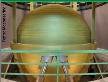
Dissipatori viscosi installati nello smorzatore a massa risonante nel grattacielo Taipei 101 (Taiwan).
