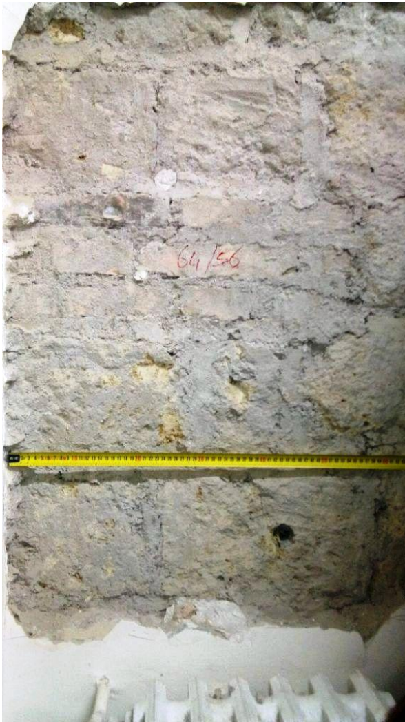
SVV17 (Parete 64-56 Piano 2°) Muratura in pietra di tufo, parzialmente regolare
