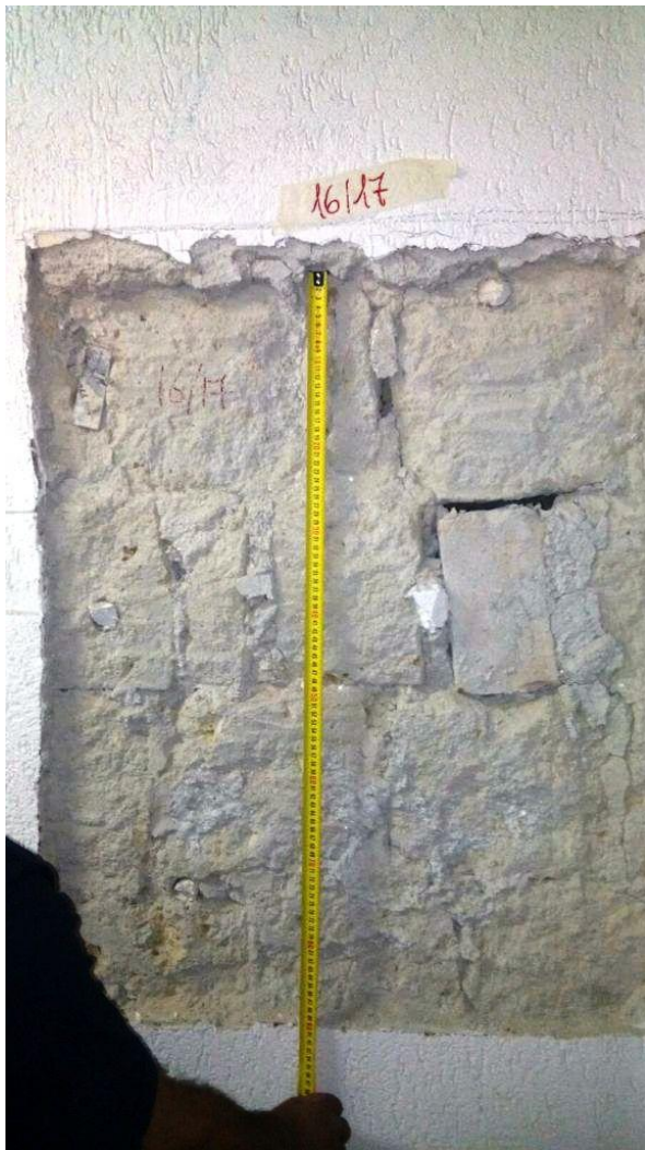
SVV12 (Parete 16-17 Piano 1°) Muratura in pietra di tufo, parzialmente regolare
