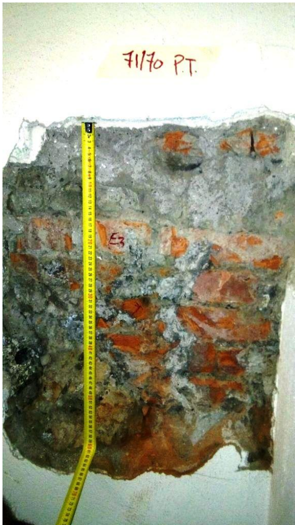
SVV10 (Parete 71-70 Piano Terra) Muratura in mattoni rossi, con listatura
