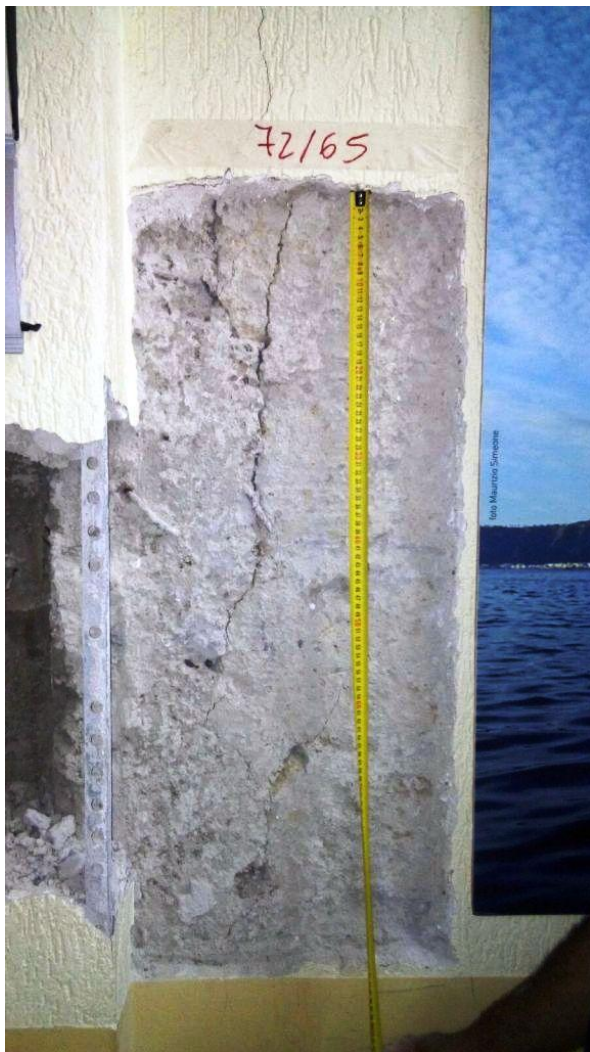
SVV26 (Parete 72-65 Piano 5°) Muratura in pietra di tufo, parzialmente regolare
