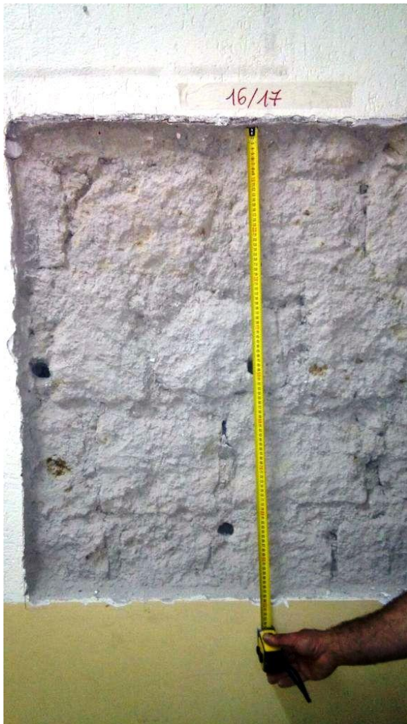
SVV20 (Parete 16-17 Piano 4°) Muratura in pietra di tufo, parzialmente regolare
