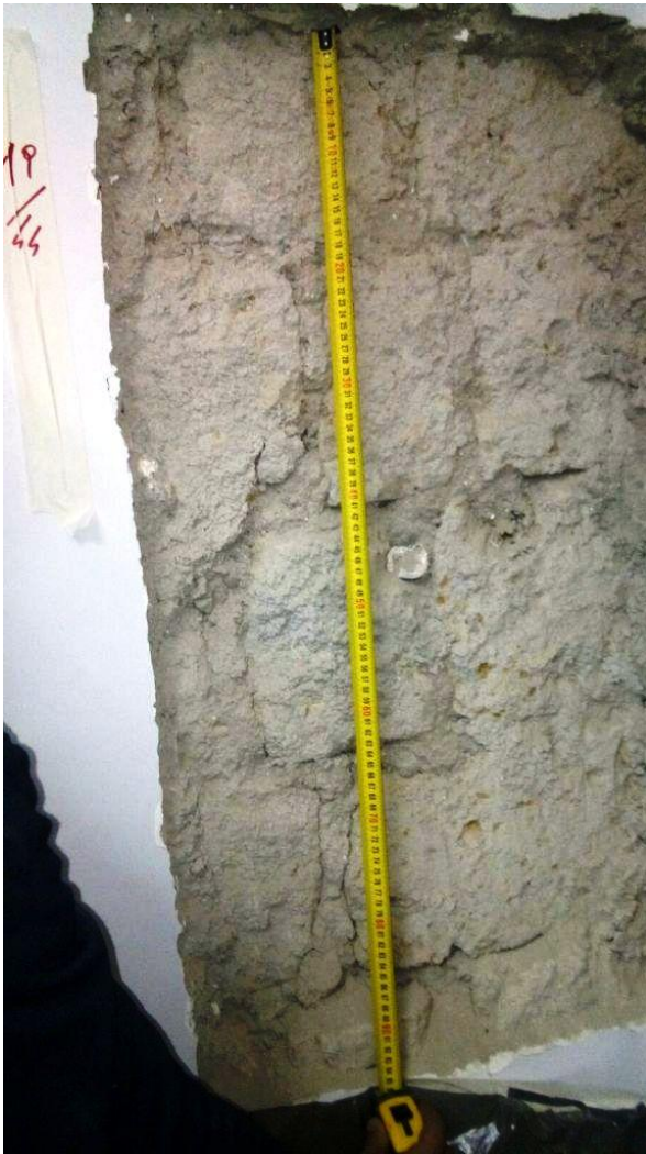
SVV21 (Parete 19-44 Piano 4°) Muratura in pietra di tufo, parzialmente regolare
