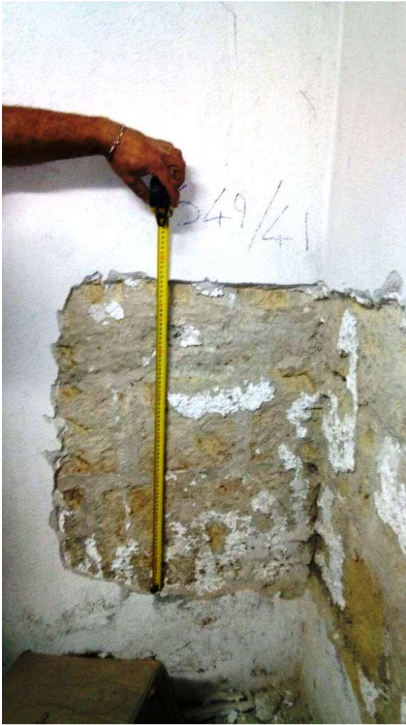
SVV4 (Parete 49-41 Piano Interrato) Muratura in pietra di tufo regolare
