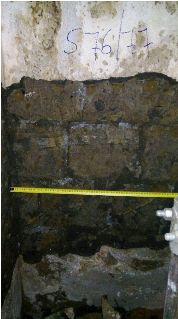
SVV6 (Parete 76-77 Piano Interrato) Muratura in pietra di tufo regolare
