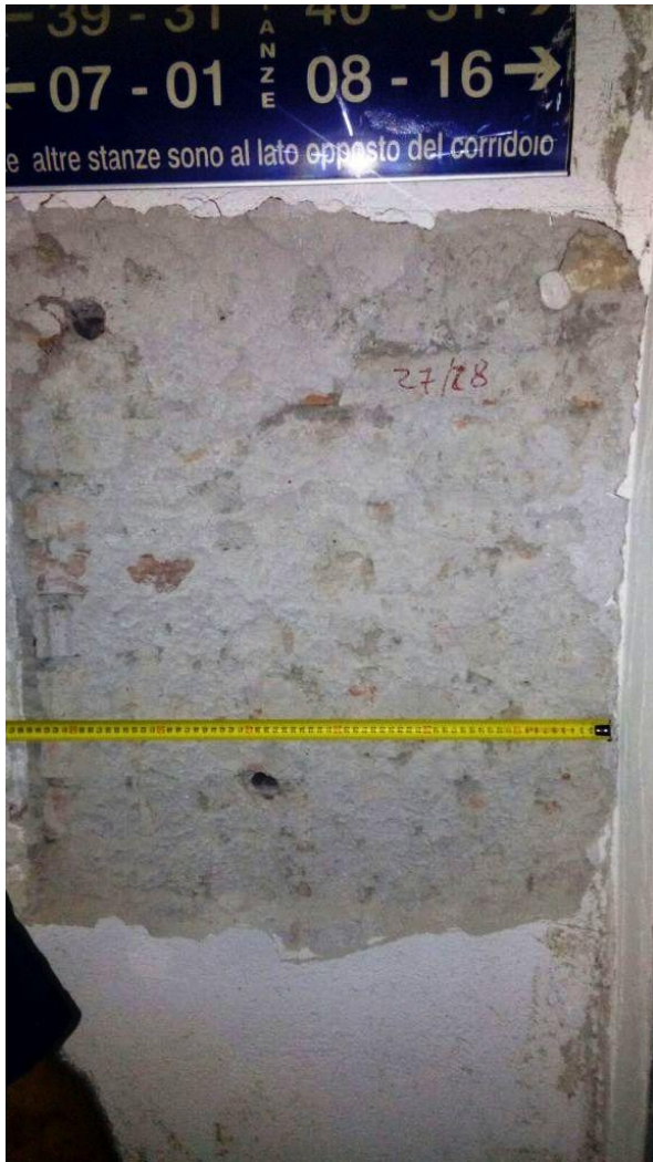
SVV14 (Parete 27-28 Piano 2°) Muratura in pietra di tufo, parzialmente regolare
