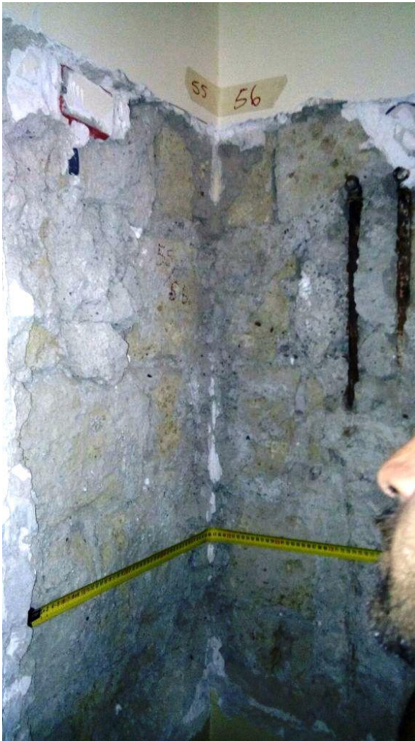
SVV7 (Parete 55-56 Piano Terra) Muratura in pietra di tufo regolare
