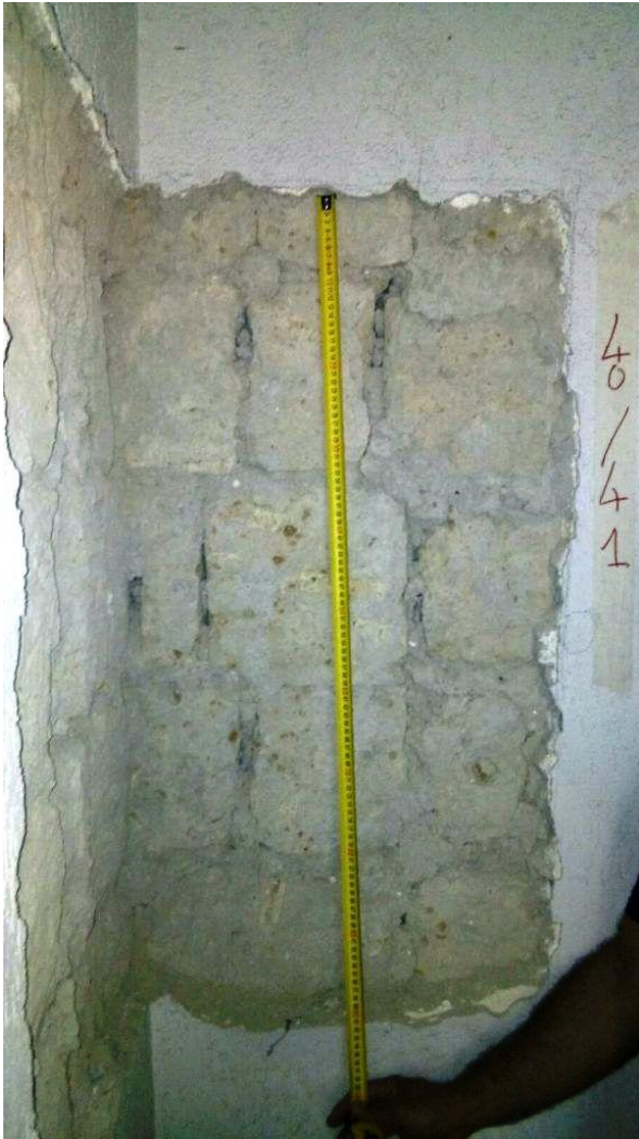
SVV24 (Parete 40-41 Piano 5°) Muratura in pietra di tufo, parzialmente regolare
