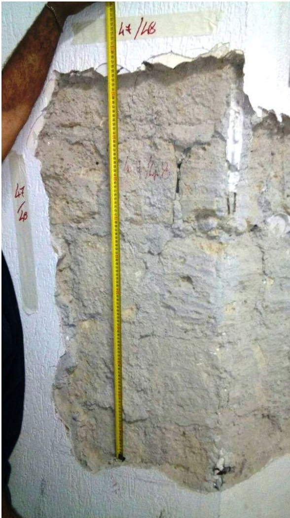
SVV15 (Parete 47-48 Piano 2°) Muratura in pietra di tufo regolare
