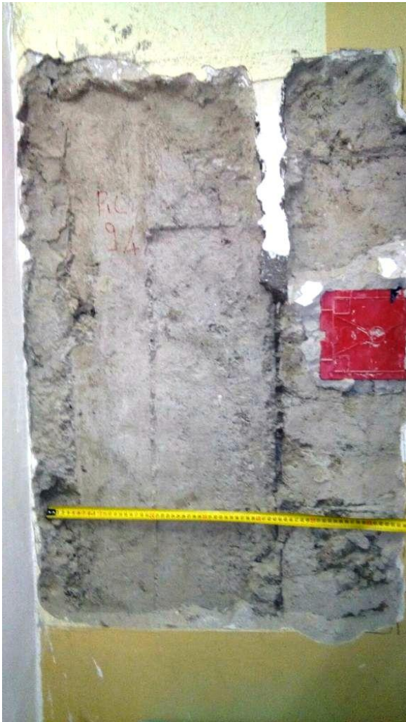
SVV27 (Pilastro 94 Piano 5°) Pilastro inserito nella muratura di tufo
