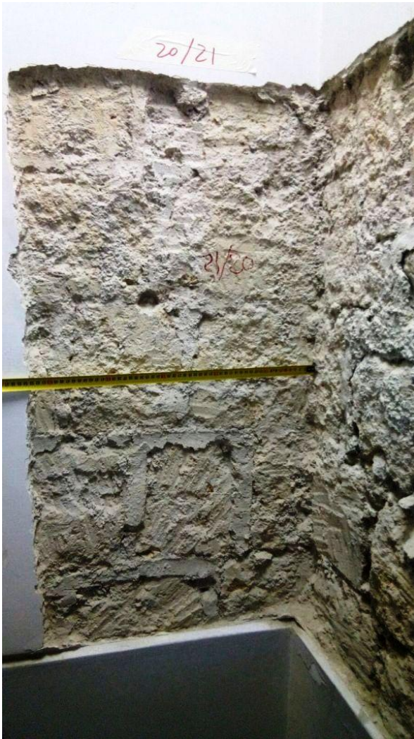
SVV13 (Parete 20-21 Piano 1°) Muratura in pietra di tufo regolare
