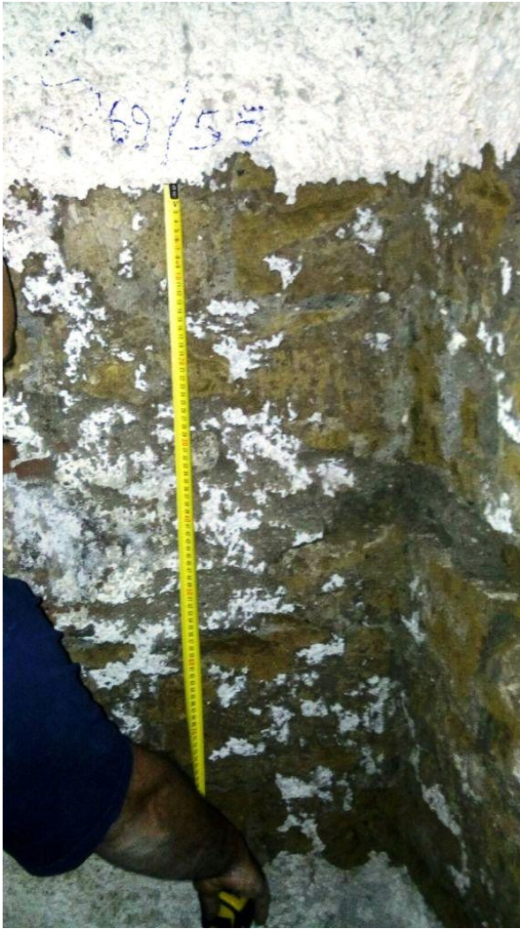
SVV5 (Parete 69-55 Piano Interrato) Muratura in pietra di tufo regolare, con listatura
