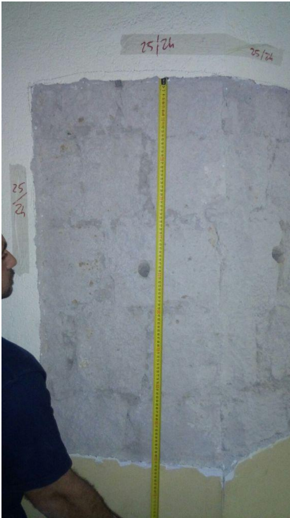
SVV22 (Parete 25-24 Piano 4°) Muratura in pietra di tufo, parzialmente regolare
