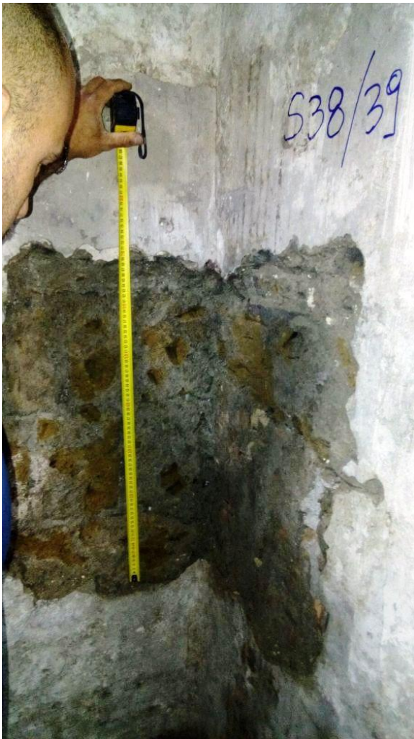
SVV2 (Parete 38-39 Piano Interrato) Muratura in pietra di tufo parzialmente regolare
