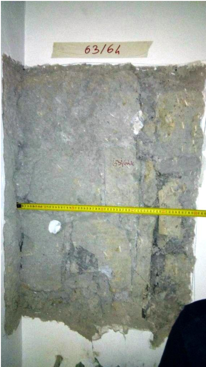
SVV8 (Parete 63-64 Piano Terra) Muratura in pietra di tufo regolare
