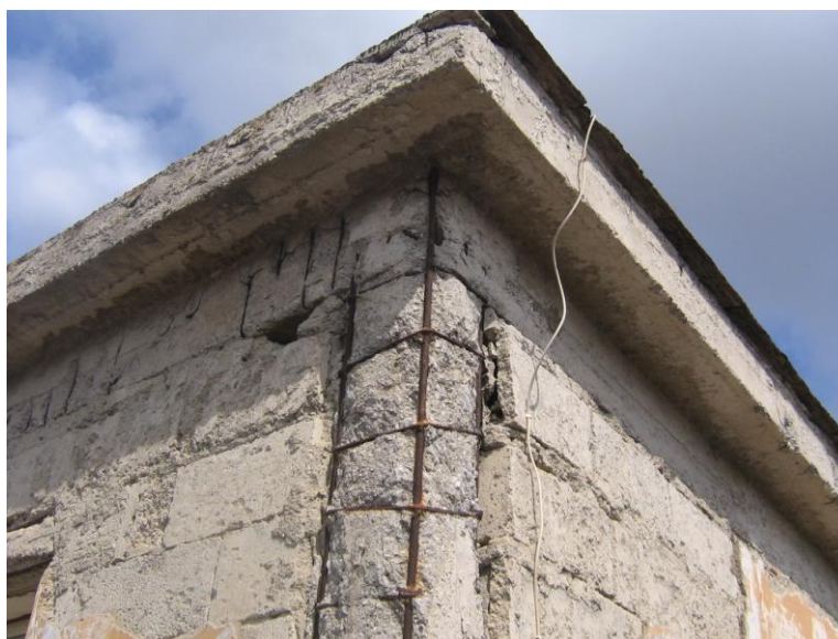
Fig.3 – particolare pilastro e nodo in cemento armato
