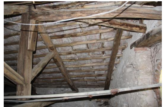
Fig. 83 - Stato di conservazione degli elementi lignei
