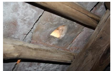
Fig. 80 - Corpo B - Tegola di areazione
