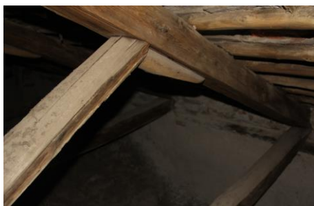
Fig. 79 Copro B - Sistema di connessione saetta-puntone
