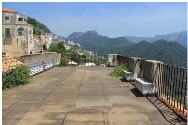
Fig. 98 Solaio T5: manto in guaina bituminosa
