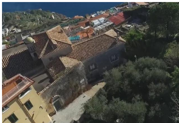
Fig. 123 - veduta lato Via Dell'Episcopo
