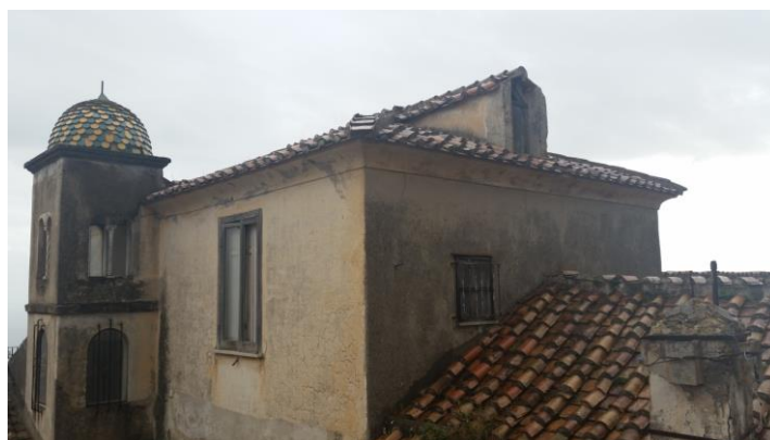
Fig. 86 - Vista dell'abbaino sulla falda orientata a Nord-Ovest
