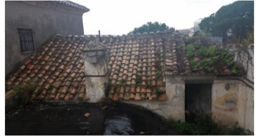
Fig. 81 - Ingresso al sottotetto A
