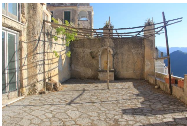
Fig. 97 Pavimentazione in pietra calcarea naturale del solaio T4
