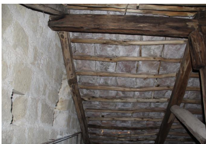
Fig. 77 - Corpo B - Struttura di copertura in capriate lignee
