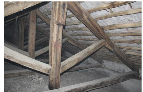
Fig. 78 - Corpo B - Particolare falda di copertura
