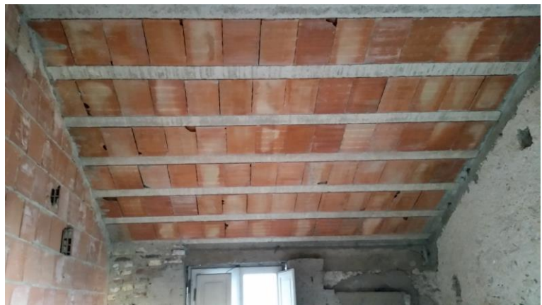
Fig. 92 – Copertura corpo E
