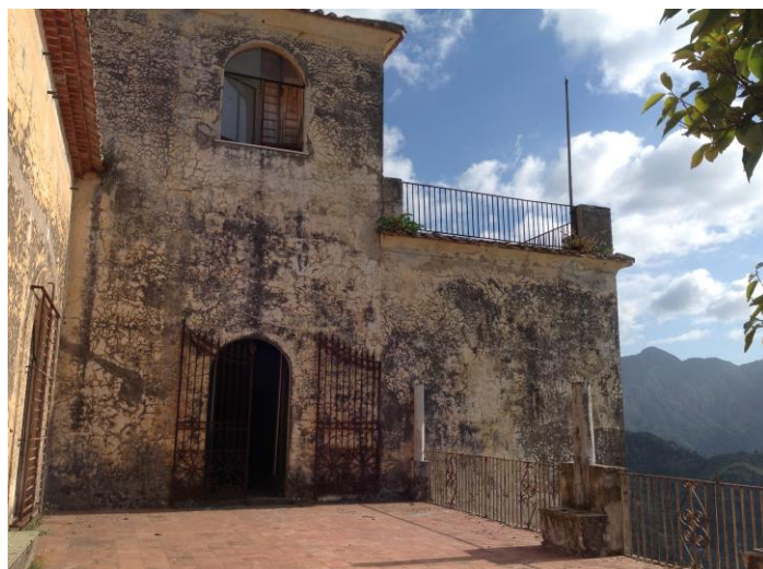
Fig.61 - Terrazza panoramica a q. 0.00
