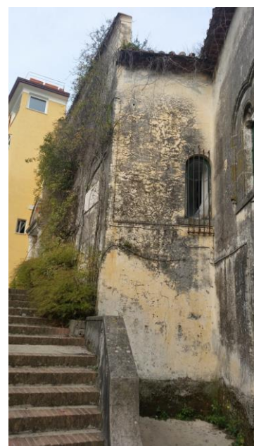
Fig. 122 - Particolare Veduta Piazzale
