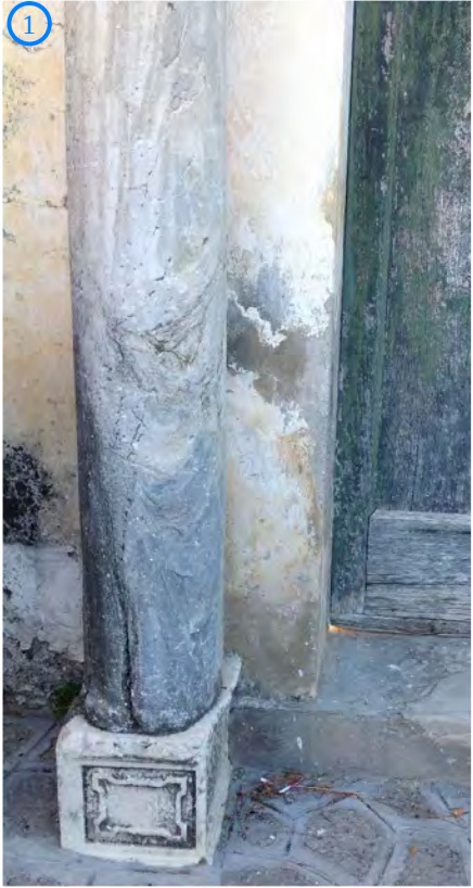
Fig.02. Portale in pietra, particolare colonna
