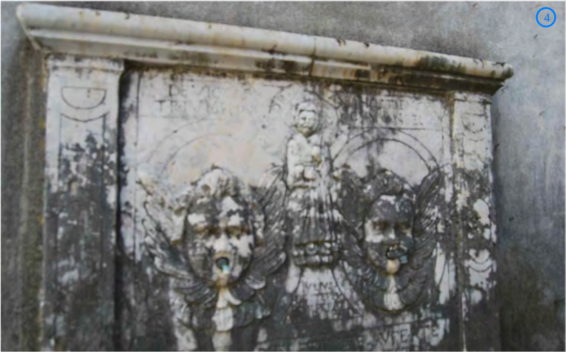
Fig.03. Foto prospetto corte nord, particolare fontana in marmo
