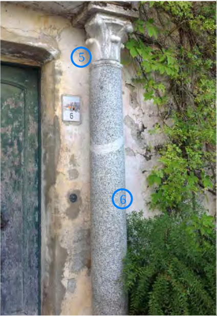
Fig.04. Portale in pietra, particolare colonna
