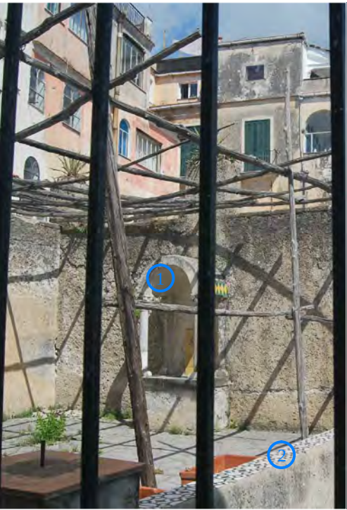
Fig.03. Foto corte nord, particolare
