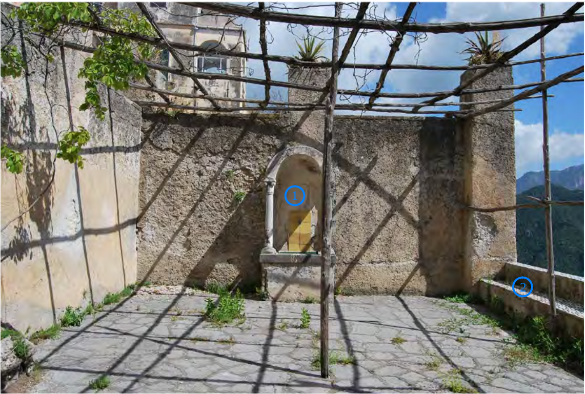
Fig.01. Foto d'insieme prospetto con fontana corte nord
