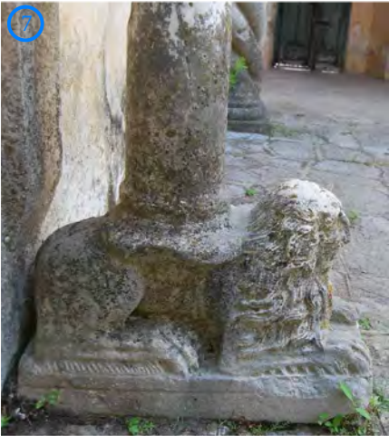
Fig.03. Foto portale d'ingresso, particolare basamento
