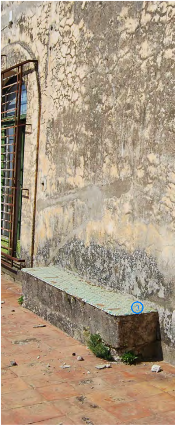
Fig.03. Foto seduta in muratura e maioliche, particolare
