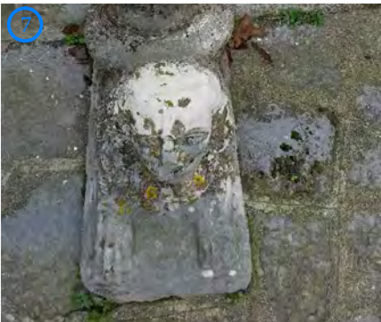
Fig.05. Foto portale d'ingresso, particolare basamento
