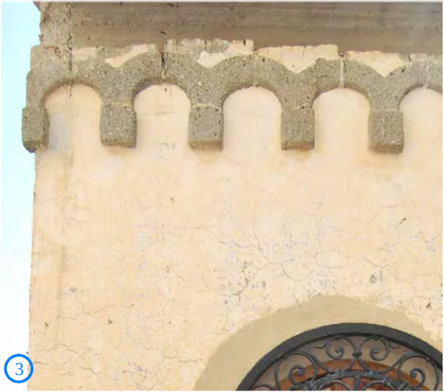
Fig.04. Foto prospetto corte nord, particolare cornice
