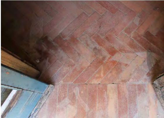
Fig.03 Foto ambiente n° 4, particolare
