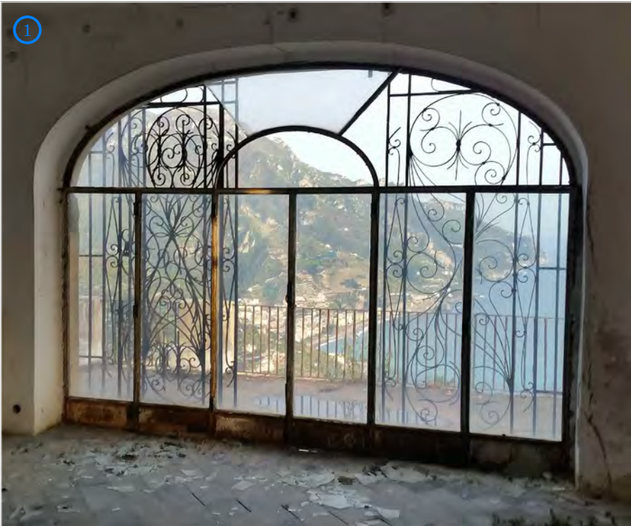
Fig.02. Foto ambiente n° 12, particolare inferriata
