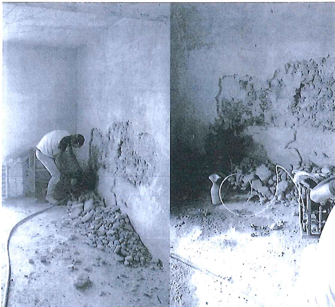
Particolare esecuzione del taglio (foto a sx), particolare esecuzione prova MS1 (foto dx)
