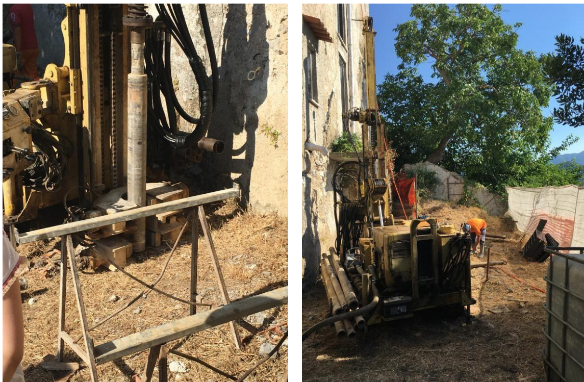
Figura 3: particolare fase carotaggio 1
