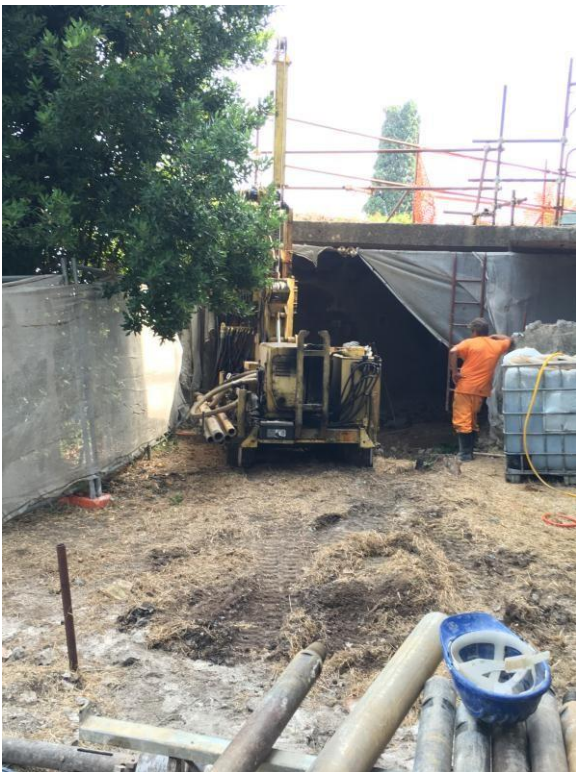
Figura 8a b: fase carotaggio 2
