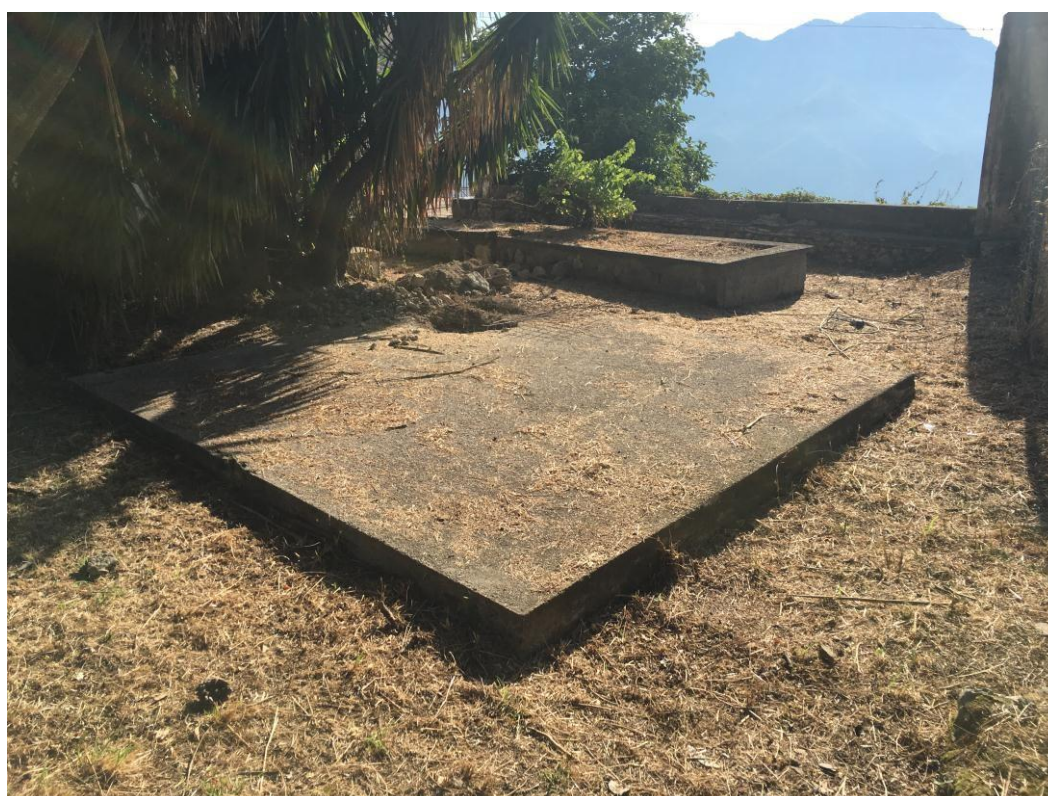
Figura 12: panoramica terrazza SW e soletta.
