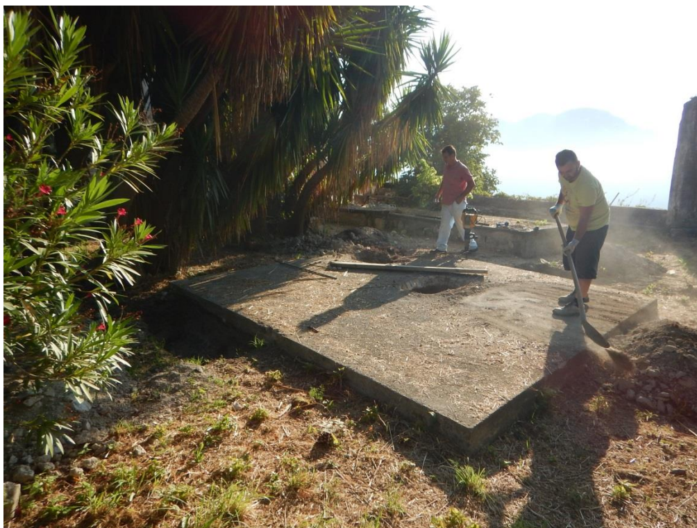
Figura 32 Saggio del 3 agosto – Terrazzo SW soletta in cemento armato.
