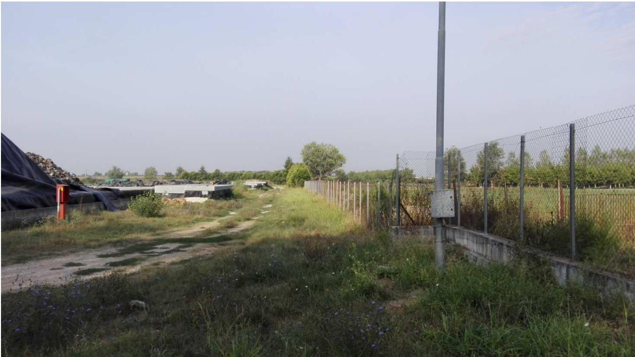
FOTO 9 – Vista interna impianto sul lato Nord
