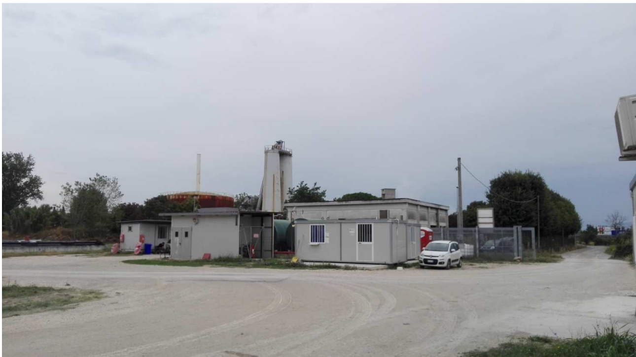
FOTO 2 – Vista zona uffici/servizi addetti e locale tecnico antincendio
