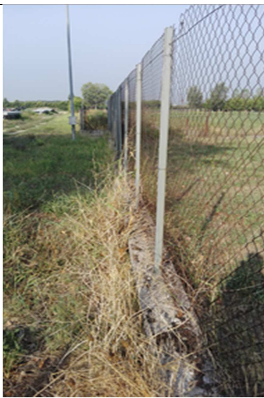
FOTO 14 – Recinzione sul lato nord con canale di scolo lungo il lato esterno
