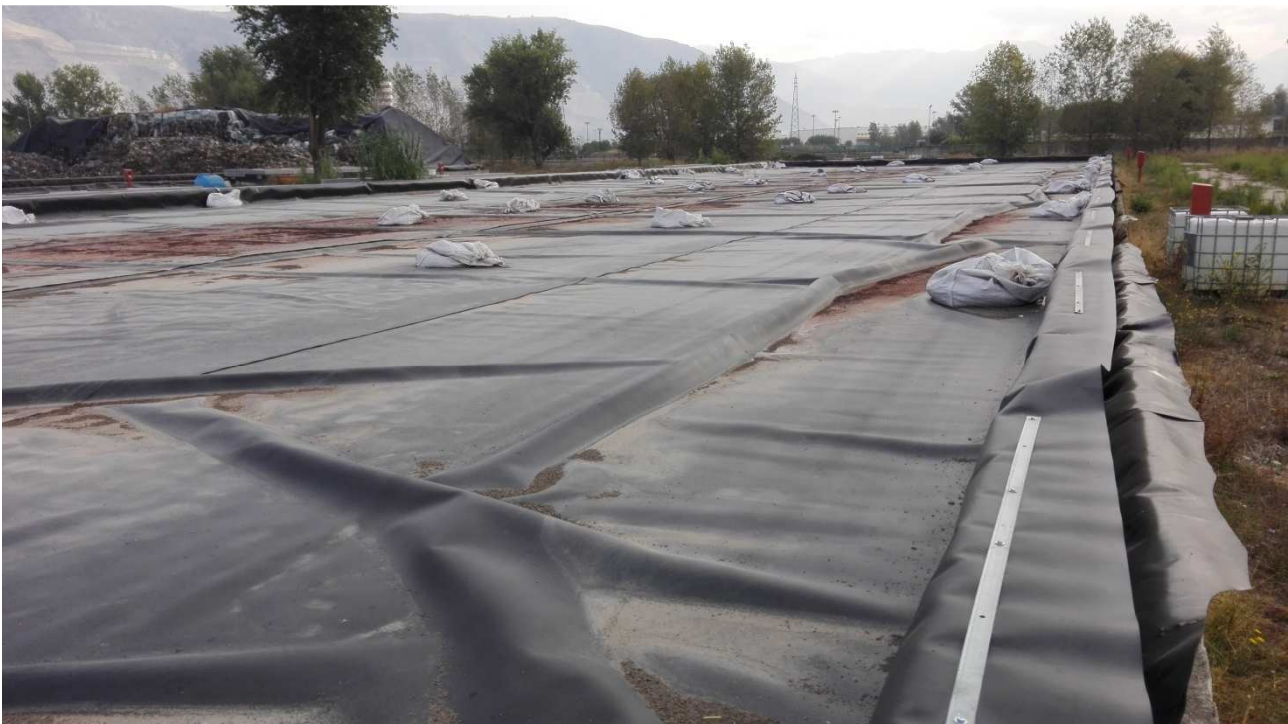
FOTO 6 - Piazzola minore completamente sgombra da rifiuti
