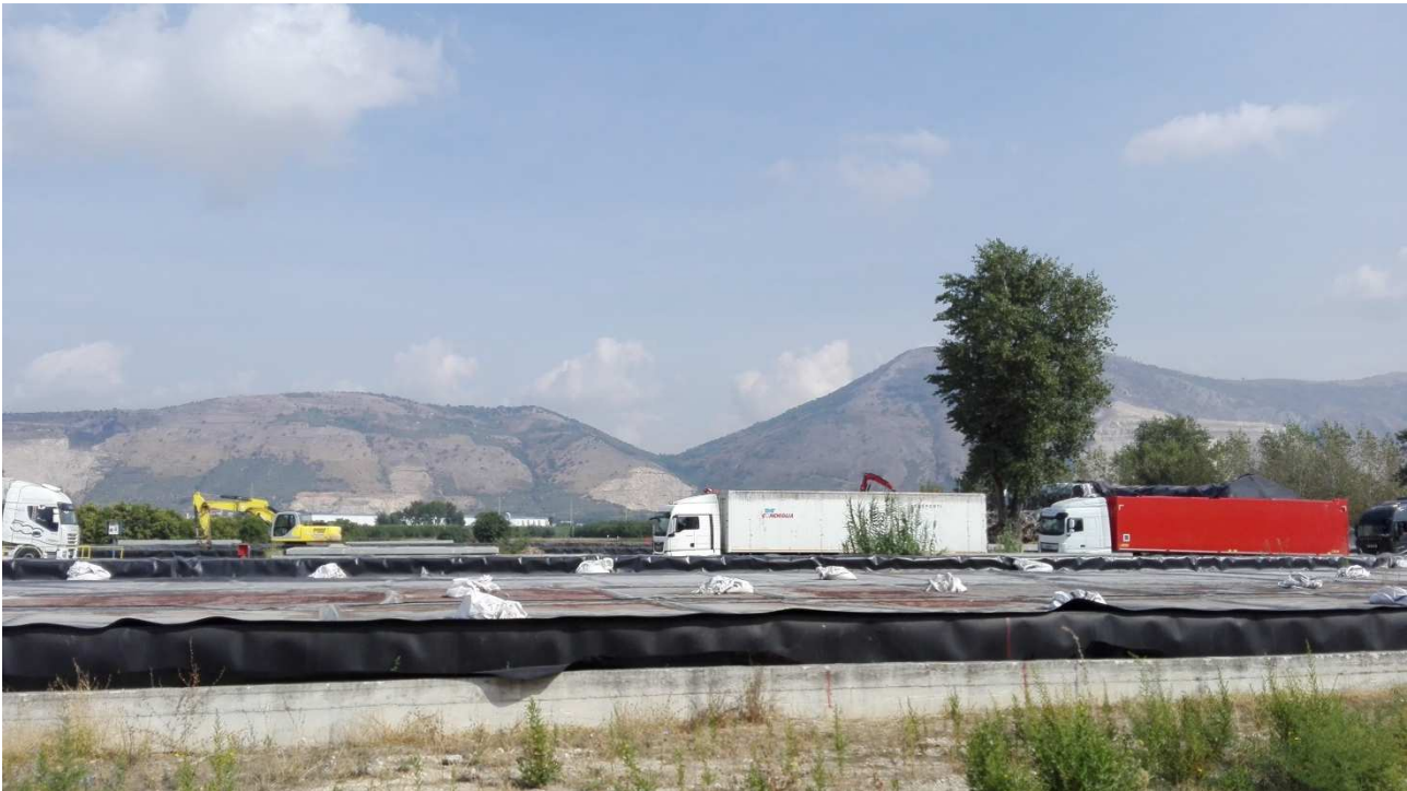
FOTO 5 - Vista delle operazioni in corso di smaltimento dei rifiuti stoccati sulla piazzola maggiore
