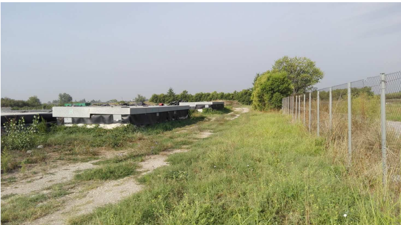
FOTO 10 – Vista interna sul alto Nord con in evidenza le cisterne di raccolta del percolato
