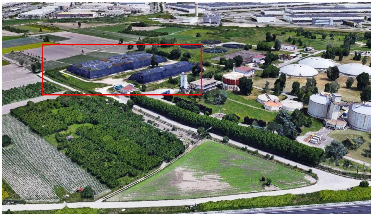
Figura 2 – Vista 3D da Google del sito oggetto d'intervento prima della rimozione delle balle
