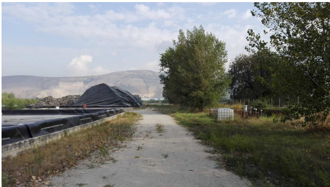
FOTO 7 – Vista dell'impianto sul lato Est
