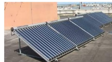
INSTALLAZIONE IMPIANTO SOLARE
