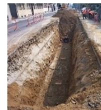
SCAVI E MOVIMENTO TERRA
