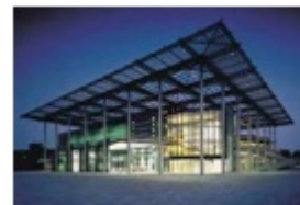
STRUTTURA IN ACCIAIO
