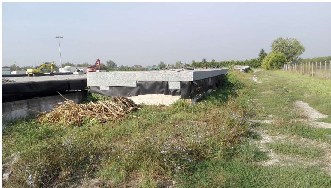
Figura 14 - Vasca di raccolta del percolato
