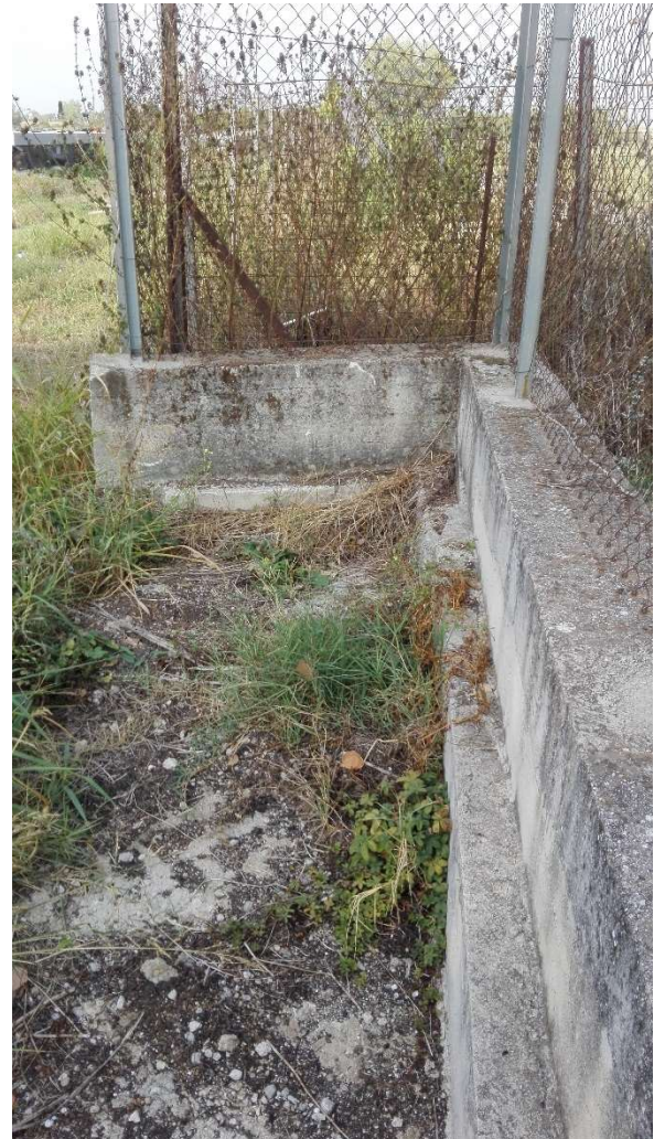
Figura 5 - Recinzione con muro in c.a. e rete metallica dell'attuale impianto
