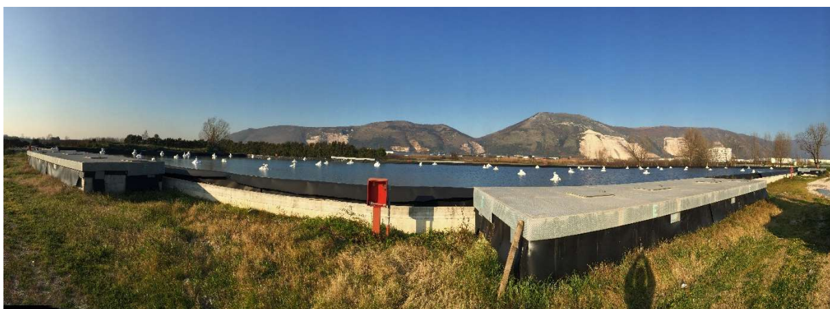
Figura 9 - Piazzola su fronte Nord
