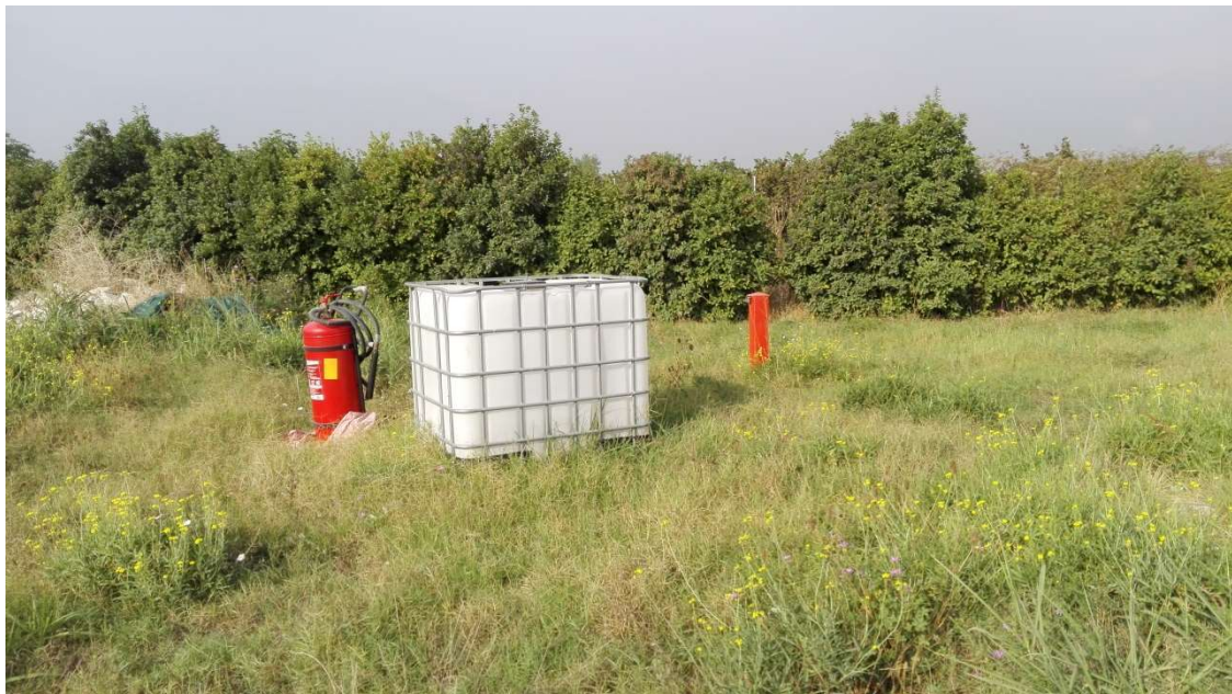
Figura 13 – Piezometri di monitoraggio falda
