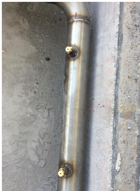
PARTICOLARE UGELLI DEL SISTEMA LAVARUOTE
