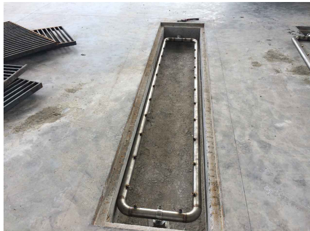
POSIZIONAMENTO TUBAZIONE ALL'INTERNO DEL SISTEMA LAVARUOTE
