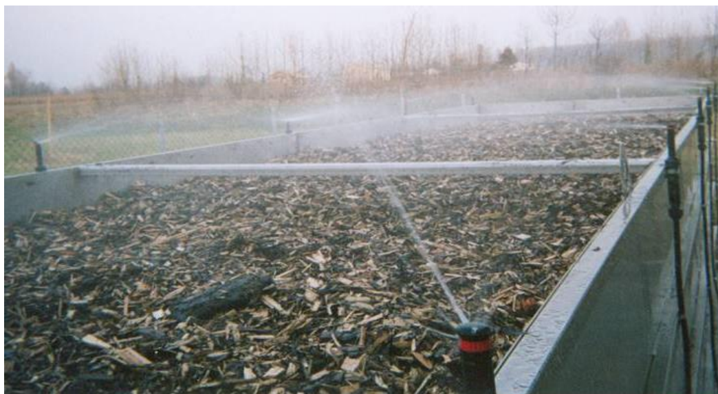
FIGURA 5-1 – ESEMPIO DI BIOFILTRO CON PARTICOLARE DEL LETTO FILTRANTE
