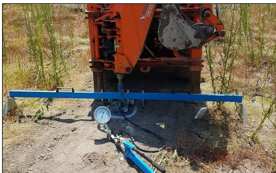
Prove di carico su piastra
