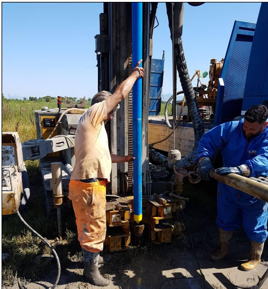
Condizionamento foro di sondaggio con piezometro a T.A.
