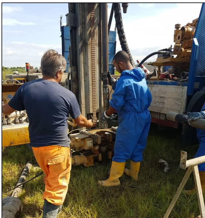
Prelievo campione indisturbato
