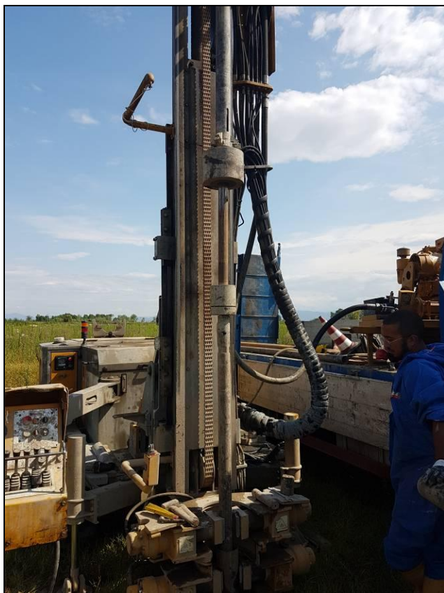
Esecuzione prova SPT
