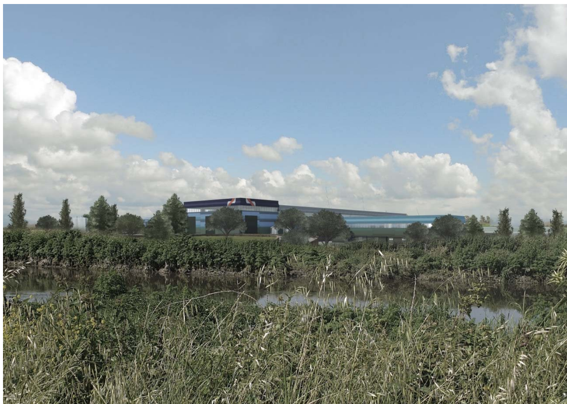
FIGURA 4-52 – VISTA DELL’OPERA DALLA SPONDA OPPOSTA DEL REGI LAGNI. DISTANZA DI 300 M
