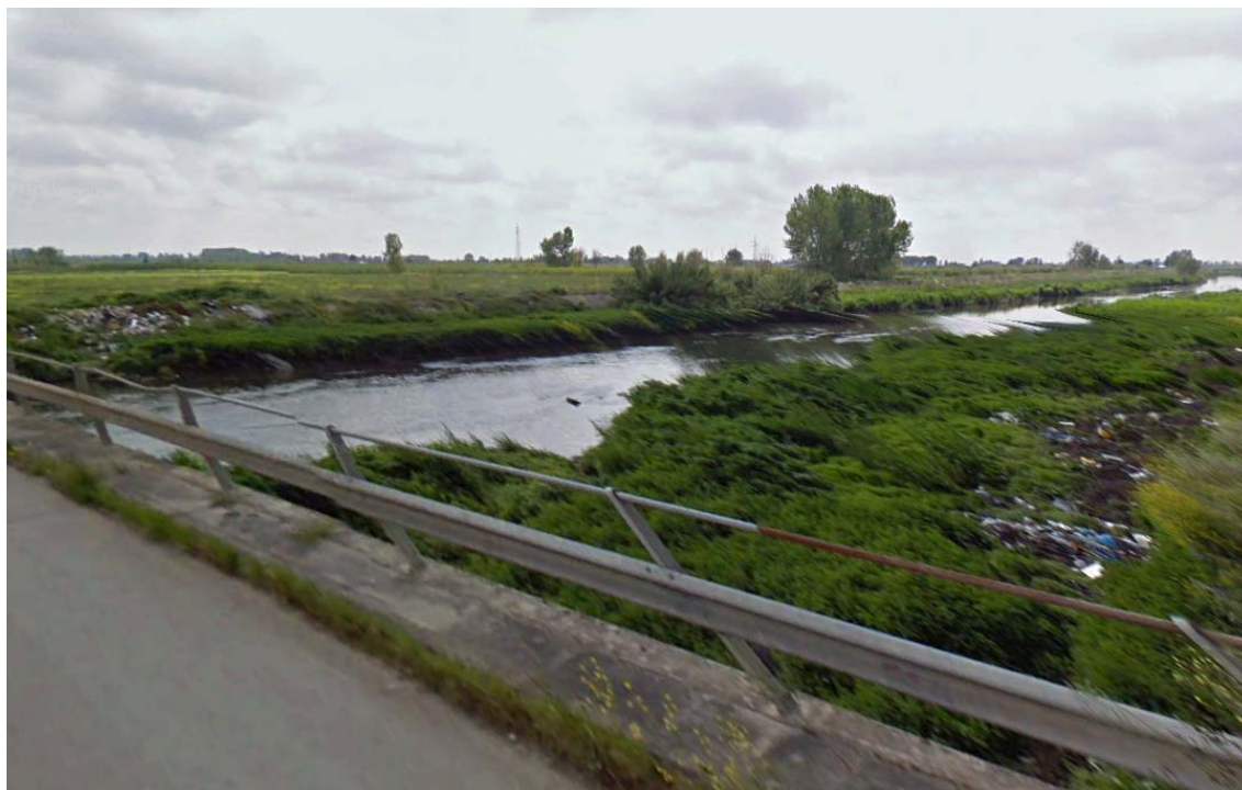
FIGURA 4-48 VISTA DALLA SP147– CONO VISIVO 2: LE ARGINATURE DEL REGI LAGNI PERMETTONO AL FRUTTORE DI ALZARE IL PROPRIO PUNTO DI VISTA
