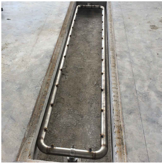
POSIZIONAMENTO TUBAZIONE ALL'INTERNO DEL SISTEMA LAVARUOTE
