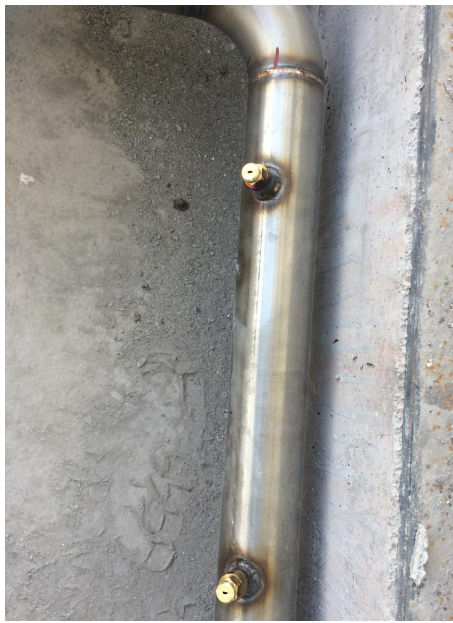
PARTICOLARE UGELLI DEL SISTEMA LAVARUOTE
