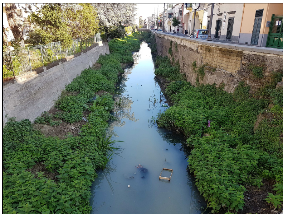
Foto n.3: acque fognarie reflue nel Bottaro in Comune di Scafati, tratto intermedio
