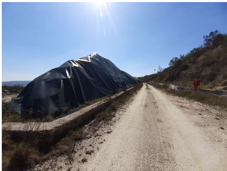
Foto 9: rete idrica antincendio
