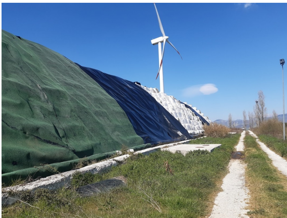
Foto 5: serbatoi del percolato
