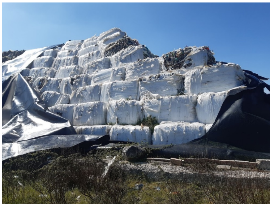
Foto 2: ecoballe con filatura deteriorata
