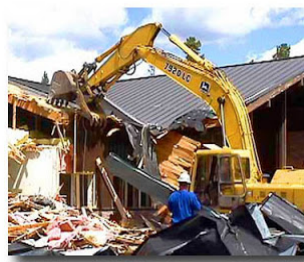
Demolizione eseguita con escavatore
