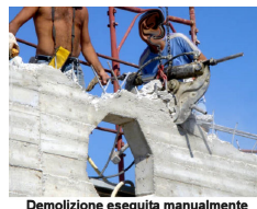
Demolizione eseguita manualmente
