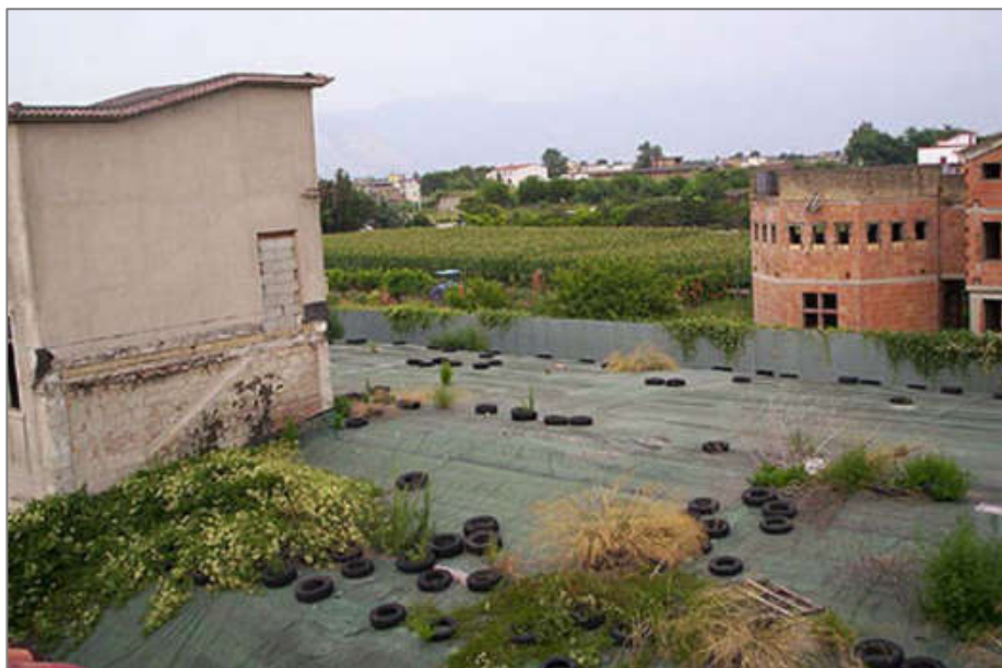
Attività di MISE post incendio (1995)
