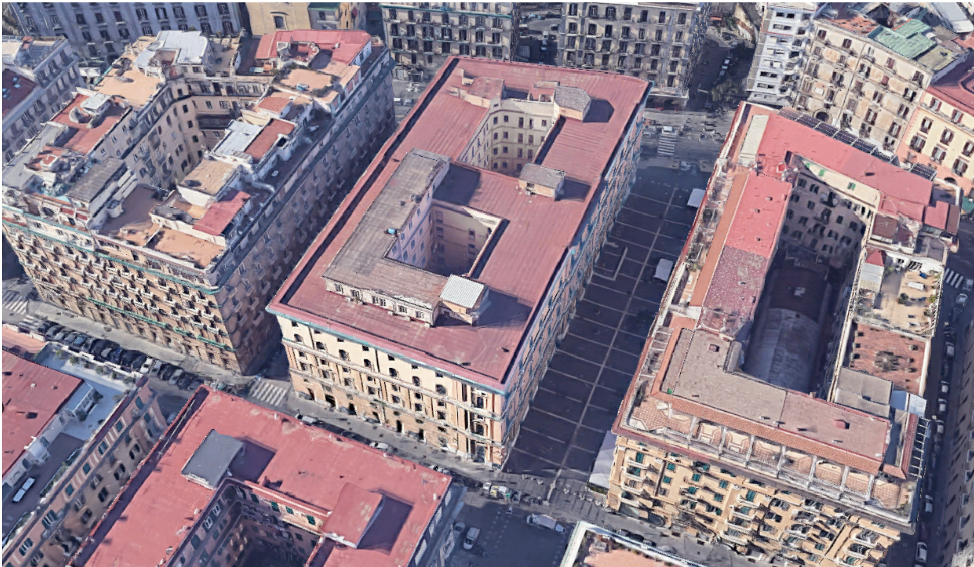
VISTA AEREA DELLA COPERTURA - STATO DI FATTO
